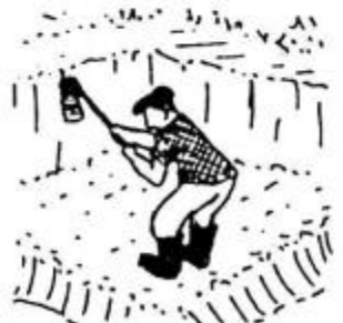
El material extraído se extiende, dejando 40 cm. de altura.
