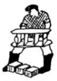
Quedando los adobes en el suelo.
