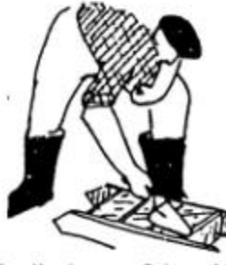
Se alisa la superficie, cuidando de recoger el exceso de barro.
