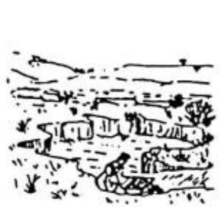
Haciéndose una excavación de 1 a 2 mts. de profundidad.
